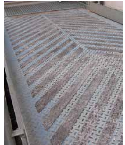
使用贝尔佐纳(Belzona) 1821 黑砂修复后的坡道
