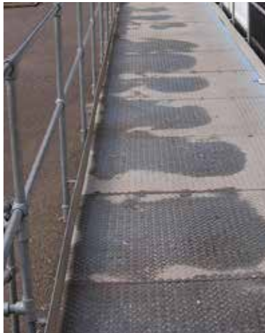
敷涂施工前的磨平钢材坡道
