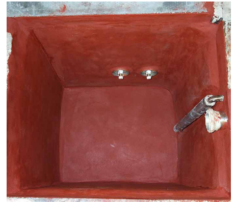
施工后的沉淀池
