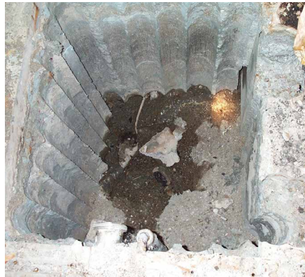
施工前的沉淀池
