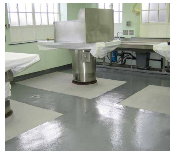
混凝土地面修复后
