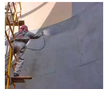
为储罐敷涂内衬
